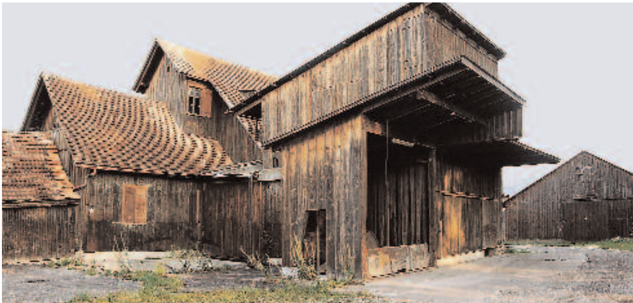
Die Kerngebäude bleiben erhalten.
